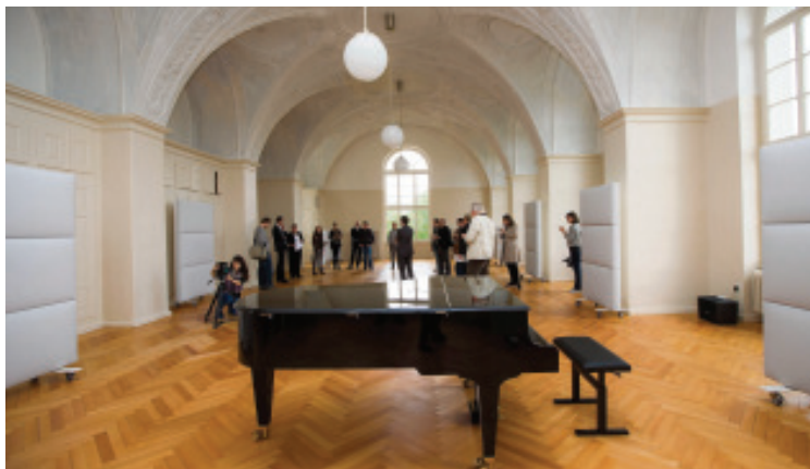
Eine der letzten baulichen Anpassungen war im November 2013 der Entscheid, die vier Millimeter Farbe von der Stuckdecke der alten Bibliothek abzulösen und diese freizulegen. Rechts und links sind mobile Akustikelemente zu sehen. Bilder Key/Mark Gasser
