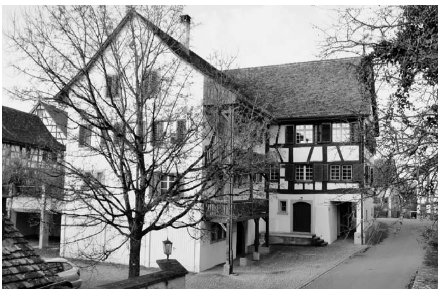
Wohnungen statt Saal: Der Anbau der Stube soll abgebrochen werden. Bild M. Gasser
